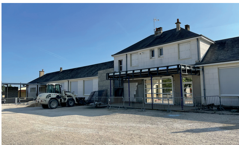
L'entrée de l'école élémentaire des Noël's se fait désormais depuis le parking, en toute sécurité.
