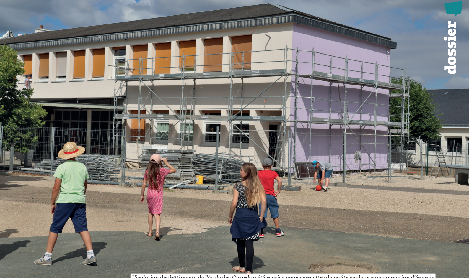
L'isolation des bâtiments de l'école des Girards a été reprise pour permettre de maîtriser leur consommation d'énergie.
