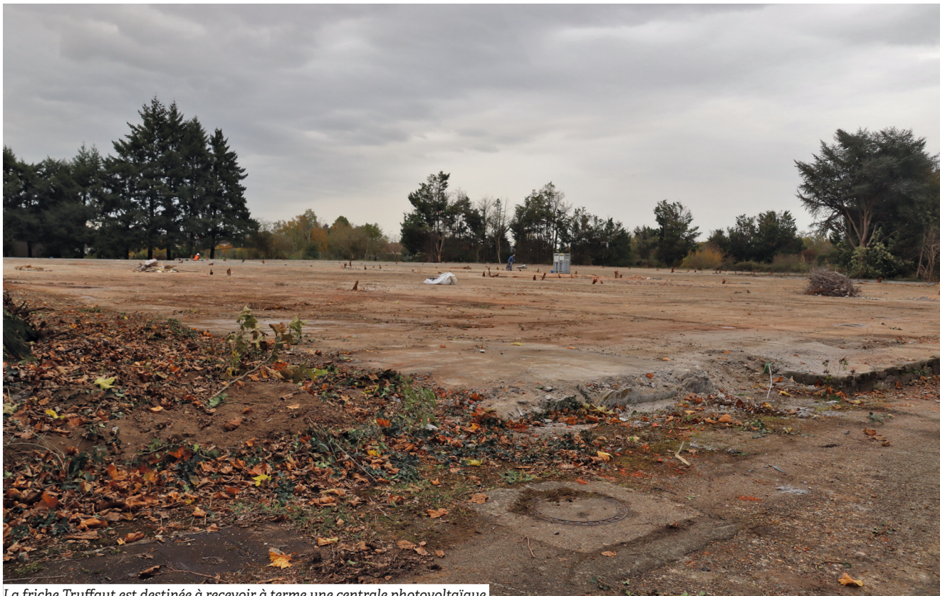
La friche Truffaut est destinée à recevoir à terme une centrale photovoltaïque.
