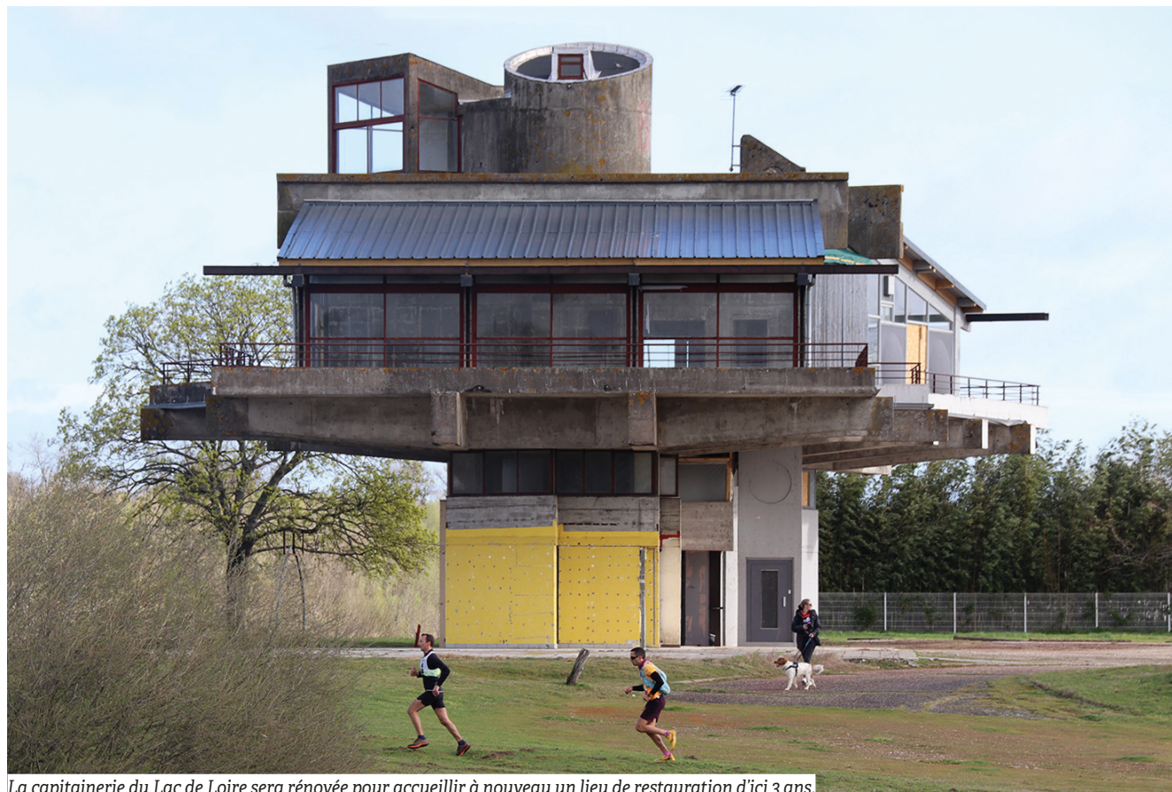
La capitainerie du Lac de Loire sera rénovée pour accueillir à nouveau un lieu de restauration d'ici 3 ans.
